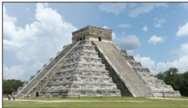
Templo de K'uk'ulkáan (Estructura 5B18) en Chichén Itzá. Pirámide radial de treinta metros de altura fechada entre 886 y 891 d. C. Las alfardas en la cara sur rematan en sendas cabezas de la serpiente emplumada. Fue orientada astronómicamente para producir un efecto de hierofanía de luz durante los
